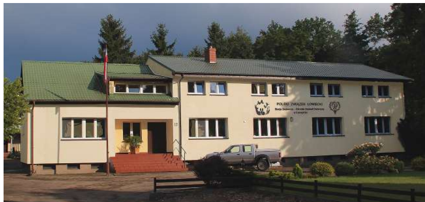
Ryc. 9. Budynek Stacji Badawczej PZŁ w Czempiniu (fot. H. Mąka)
